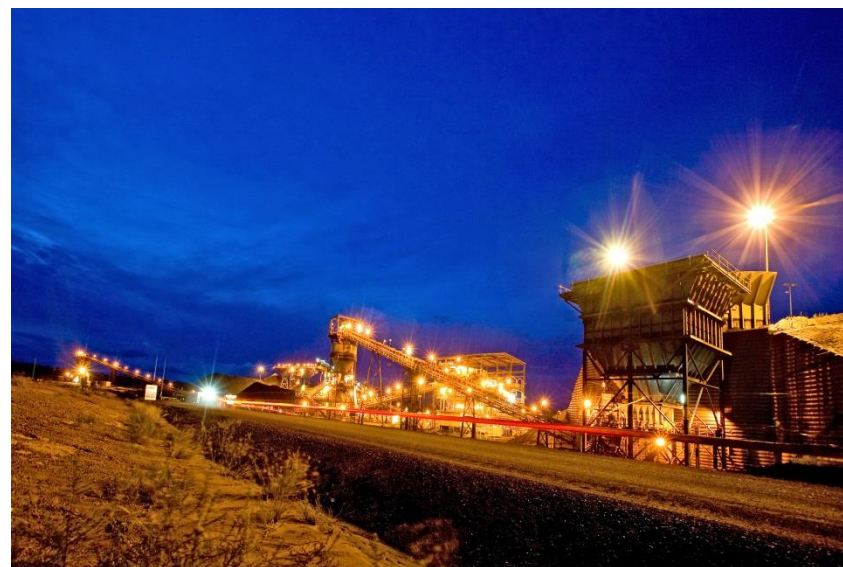
Coppabella煤矿选煤厂
